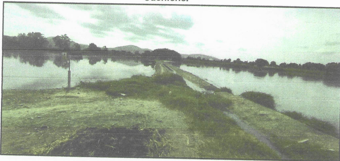
Fotografía N°05: Laguna Primaria y Laguna Secundaria n°1 de la PTAR Cachiche.
