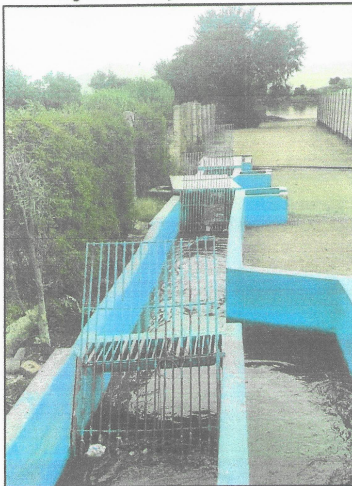
Fotografía N°01: Rejilla de la PTAR Cachiche.
