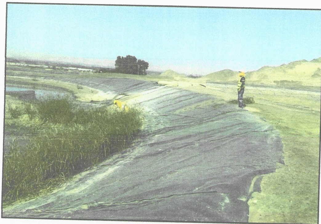
Fotografía N°09: Geomembrana de la PTAR Yaurilla.
