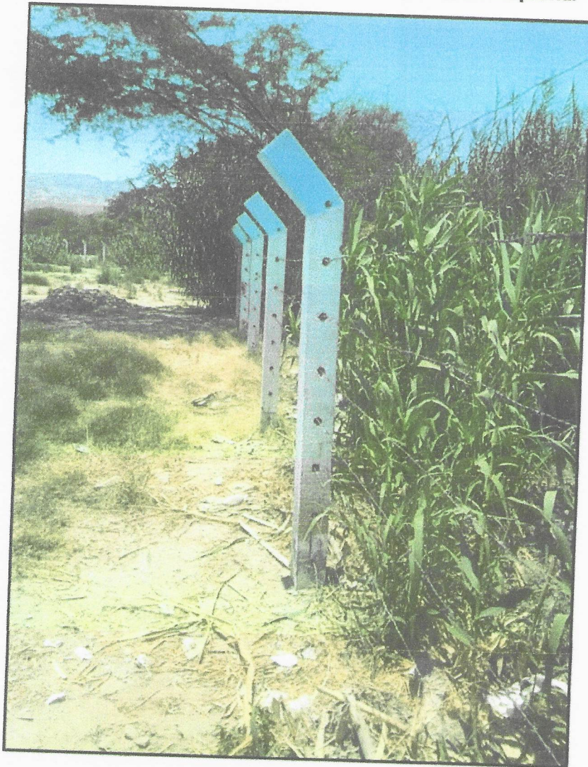
Fotografía N°17: Cerco perimétrico de la PTAR Chipiona.
