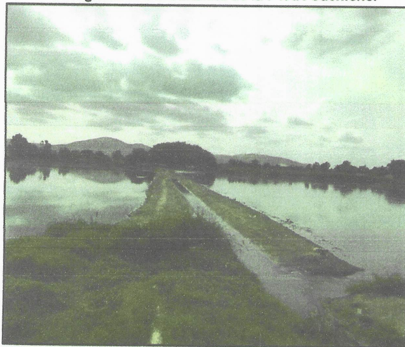
Fotografía N°04: Canaleta de la PTAR Cachiche.
