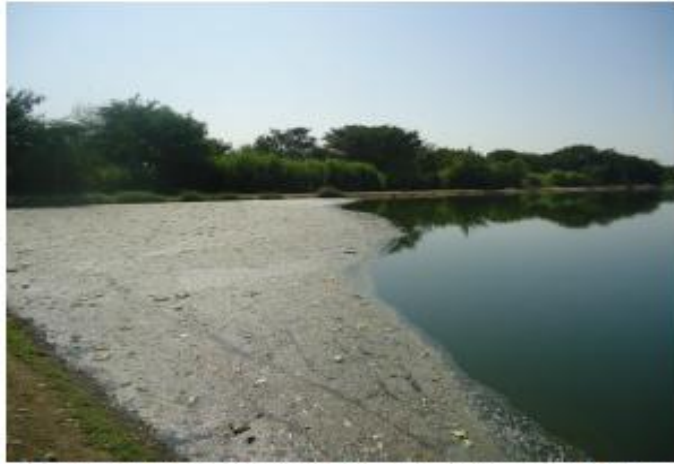
Foto 4. Lagunas sin mantenimiento adecuado, inmensas natas sobre el espejo de agua impiden tratamiento adecuado..
