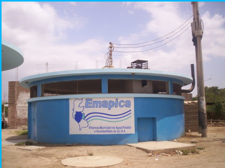
Los afluentes del emisor que vienen de la Cámara de rebombeo llegan a las lagunas cursan hacia una Cámara de distribución y de allí a las lagunas primarias 1 y 2.
